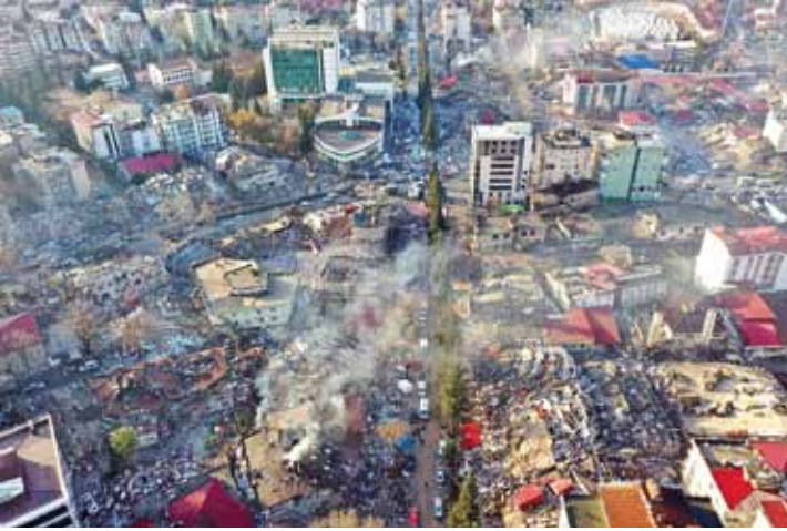
Kahramanmaraş kent merkezinde bulunan Trabzon Caddesi'ndeki çok sayıda bina yıkıldı.
