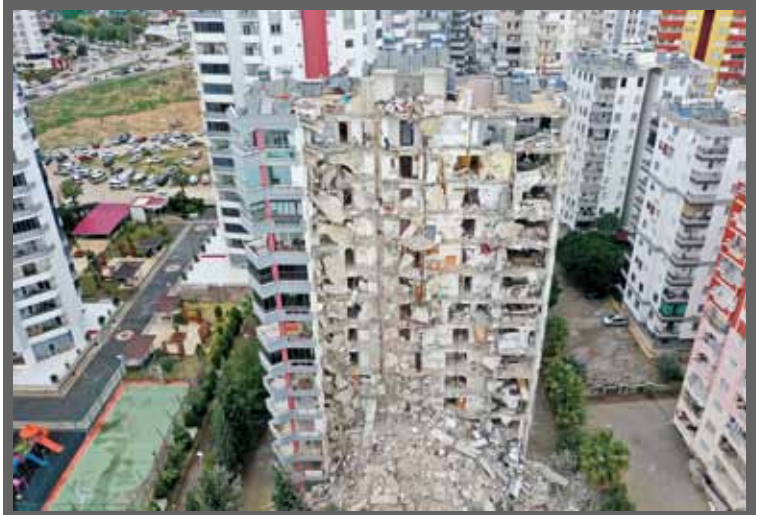
Adana'nın merkez Çukurova ilçesi Güzelyalı mahallesinde, 81189 sokakta yıkılan 12 katlı binada arama kurtarma çalışmaları yürütülüyor.
