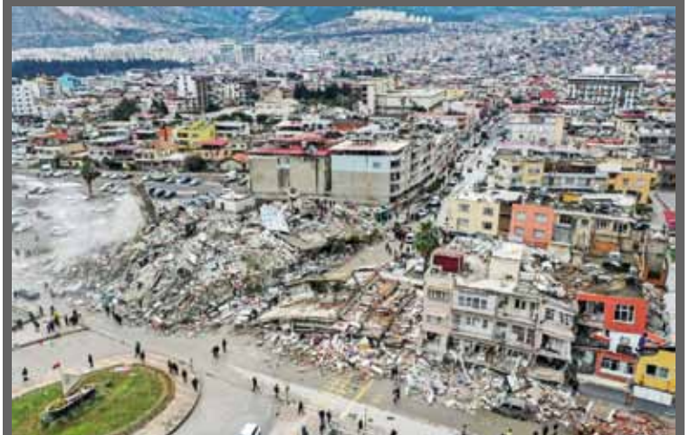
Deprem nedeniyle Hatay'ın İskenderun ilçesindeki Dr.Muammer Aksoy Caddesi'nde binalar yıkıldı.
